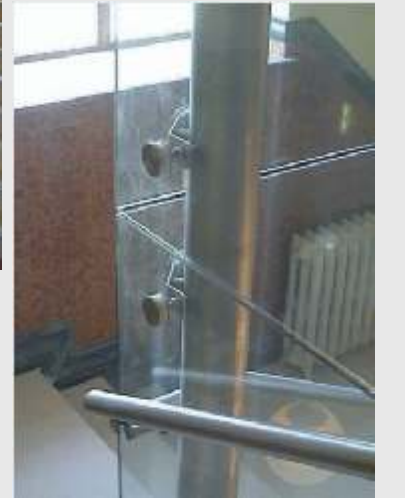
PANAROMİK ASANSÖR CAM KAPLAMA VE KÜPEŞTE MONTAJ DETAYI
