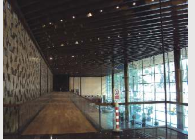
YÜRÜYEN MERDİVEN VE KÖPRÜ ALINLARI PASLANMAZ ÇELİK KAPLAMA VE KORKULUKLARI
