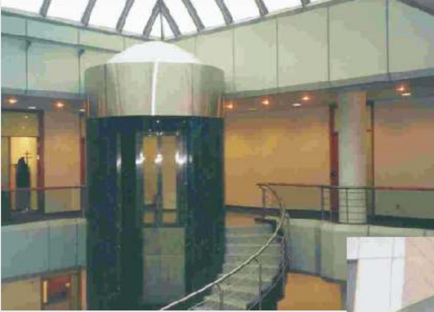
ASANSÖR CEPHESİ VE MERDİVEN KORKULUKLARI
