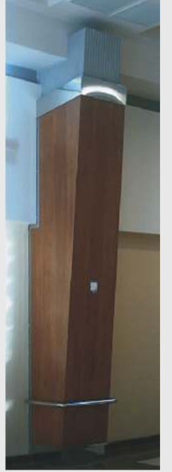
DÜZ FORMLU AHŞAP KOLON KAPLAMA
