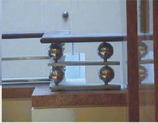
PASLANMAZ ÇELİK PARAPET ÜSTÜ KORKULUKLAR
