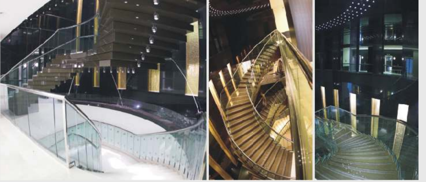
ANA MERDİVEN ÇELİK KONSTRÜKSİYON ÜZERİ CAM KAPLI GÖVDE VE CAM KORKULUKLARI
