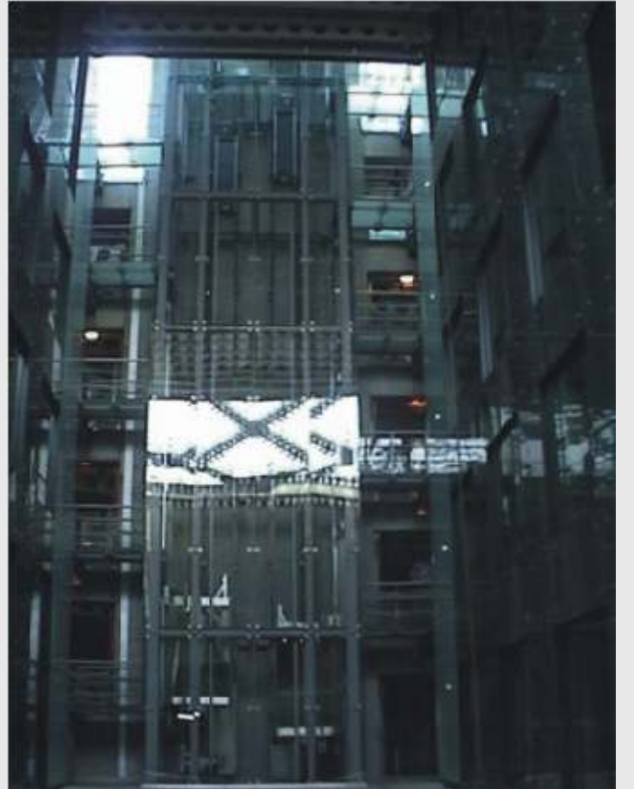
OTOPARK ASANSÖRÜ PLANAR SİSTEM CAM GİYDİRME
