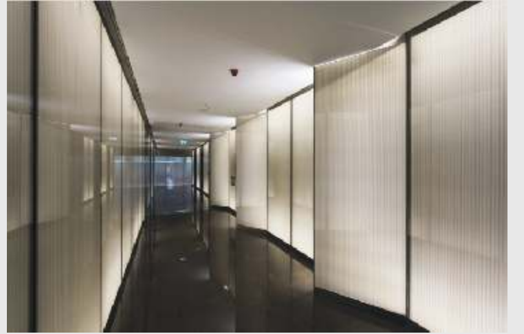
KAT HOLLERİ ASANSÖR CEPHELERİ PASLANMAZ ÇELİK VE CAM KAPLAMALAR
