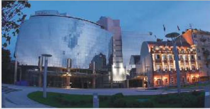
ANA MERDİVEN ÇELİK KONSTRÜKSİYON ÜZERİ CAM KAPLI GÖVDE VE CAM KORKULUKLARI
