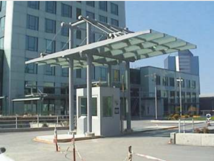
ÇELİK KONSTRÜKSİYON VE CAMLI SAÇAK
