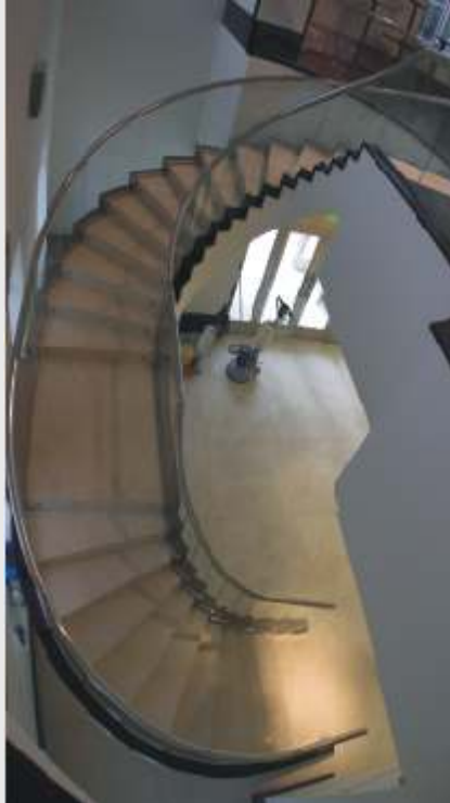
BETONARME GÖVDELİ MERDİVEN
