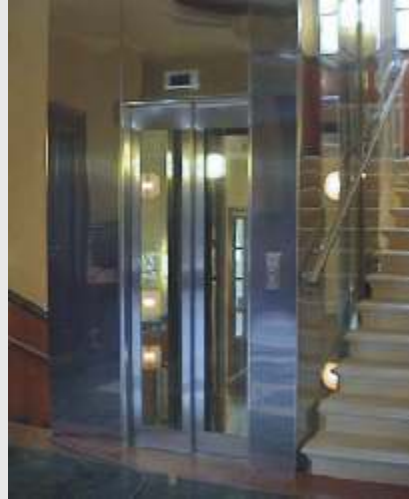
PANAROMİK ASANSÖR CEPHELERİ CAM VE PASLANMAZ ÇELİK KAPLAMALAR
