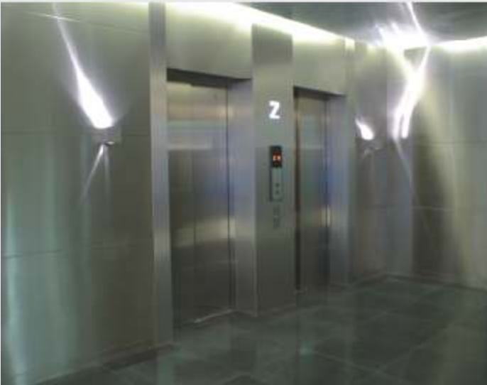
PASLANMAZ ÇELİK KAPLAMA ASANSÖR CEPHELERİ
