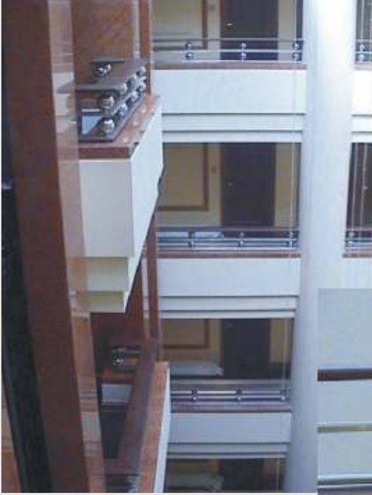
PASLANMAZ ÇELİK PARAPET ÜSTÜ KORKULUKLAR
