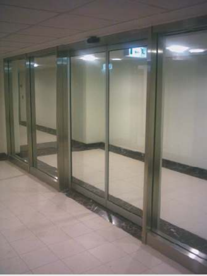
PASLANMAZ ÇELİK DOĞRAMALI KAYAR KAPILAR
