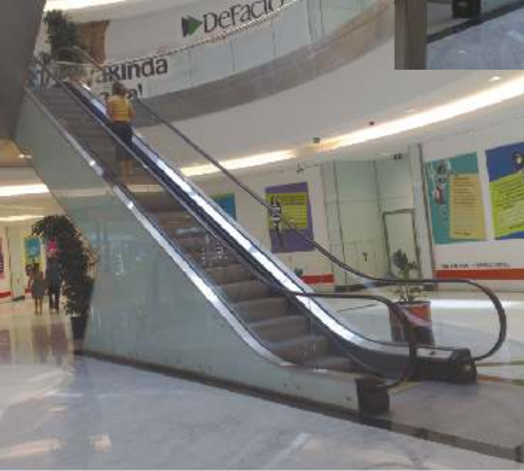
YÜRÜYEN MERDİVEN GÖVDELERİ PASLANMAZ ÇELİK VE CAM KAPLAMALARI
