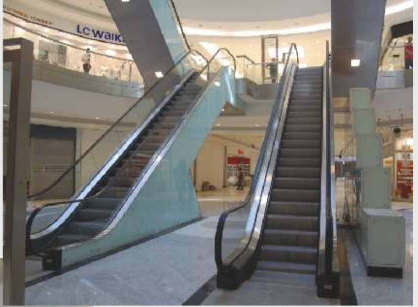
YÜRÜYEN MERDİVEN GÖVDELERİ PASLANMAZ ÇELİK VE CAM KAPLAMALARI
